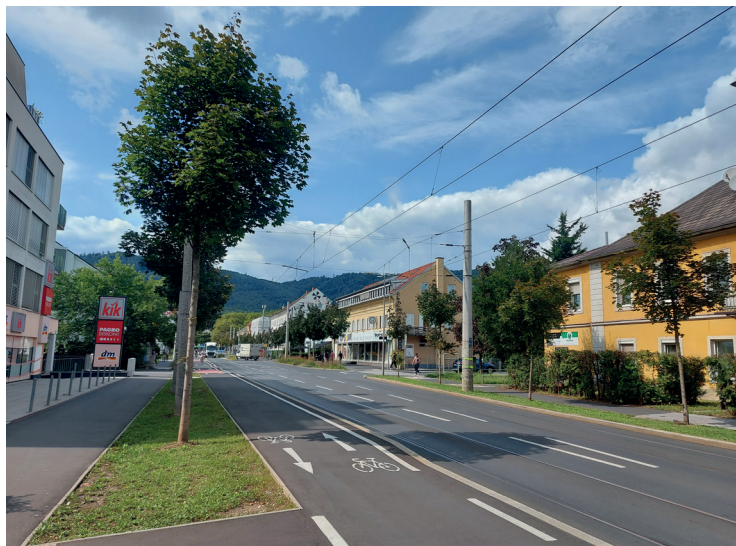
Abb. 11: Schwammstadt-anlage, Graz (A14)
