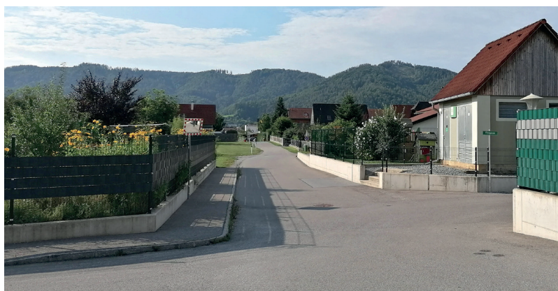
Abb. 13: Notwasserweg mit Ableitung in ein Versickerungsbecken, Gratwein-Straßengel (A14)
