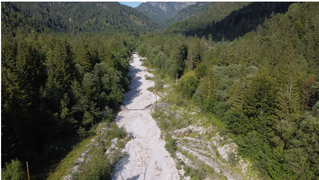
Abb. 2: Massive Verbauungen im Holzäpfeltal unterbinden die natürliche Dynamik.
