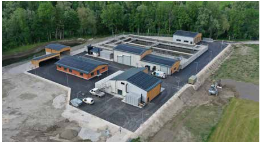
Ansicht der neuen Anlage aus Richtung Süden. Im Vordergrund die Schlammhalle, links davon das Betriebsgebäude sowie Carport und Waschplatz. Dahinter Werkstätte und Technikraum, Rechengebäude und Notstromaggregat © Firma HABAU
