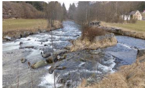
Abb. 3-45: Ausleitung Sachendorferbach [Sommer 2019], Überlauf RW-Abgabe, Fkm 6,16
