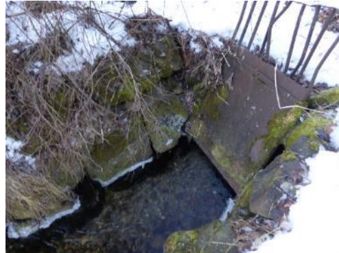
Abb. 3-47: Ausleitung Frauenbach, Fkm 5,63
