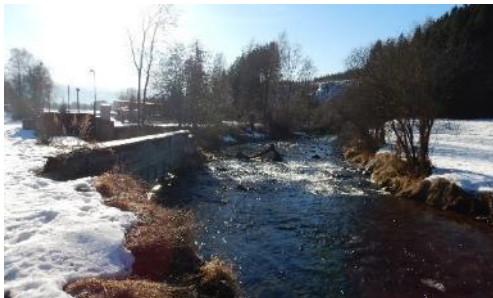
Abb. 3-44: Ausleitung Sachendorferbach, Fkm 6,16
