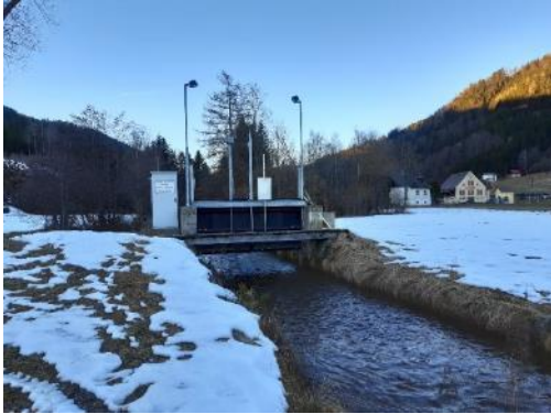
Abb. 3-10: Sachendorferbach nach Ausleitung, Fkm 6,14
