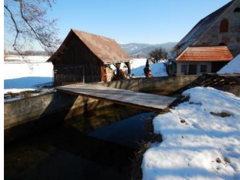
Abb. 3-43: KW Gruber, bachauf KW, Fkm 2,94
