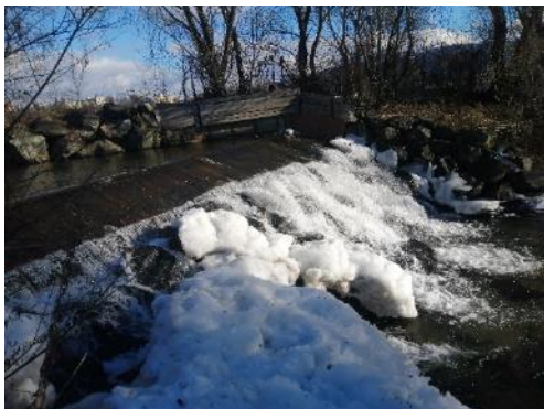
Abb. 3-40: KW Uitzmühle Ausleitung, Fkm 0,91
