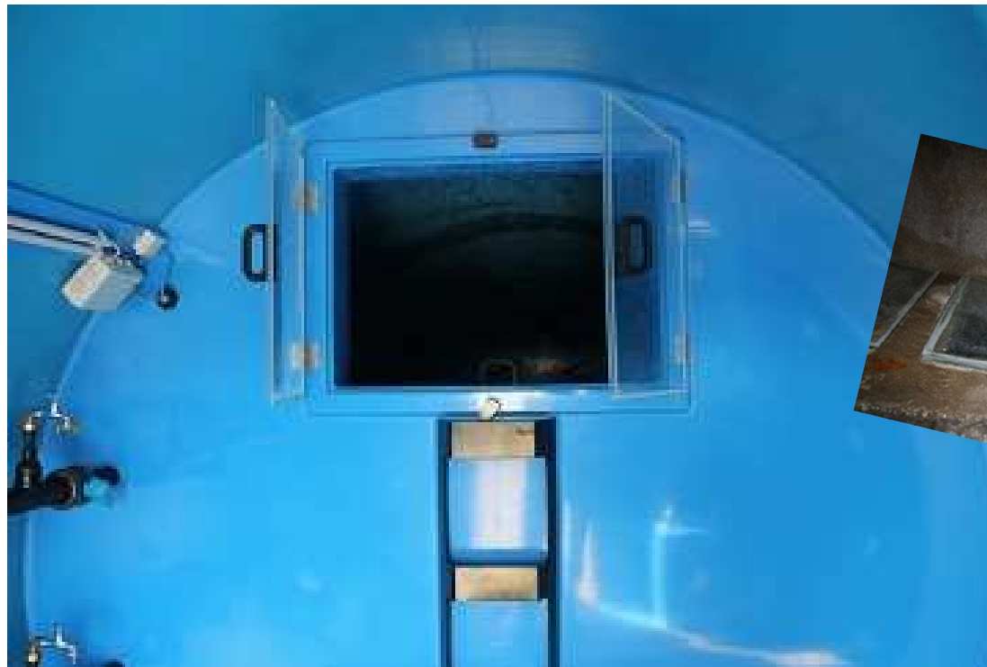
neuer Hochbehälter mit Vorkammer
