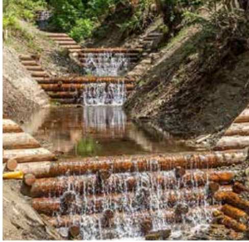
Abb. 3: Filtersperren, Grabenkonsolidierungen mit Betonsperren und Krainerwänden, Gerinneregulierungen u. a. m. wurden errichtet. © Gemeinde Gasen
