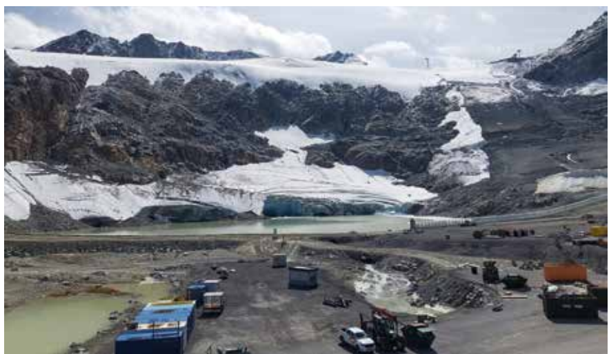
Abb. 6: Jüngst eisfrei gewordene Flächen in Gletscherschengebieten sind im Sommer Großbaustellen – am Rettenbachferner (Öztaler Alpen) wurde 2023 sogar die Gletscherzunge (rechts) abgetragen und der Untergrund zur Schipiste geplant. © Alpenverein Innerörtal
