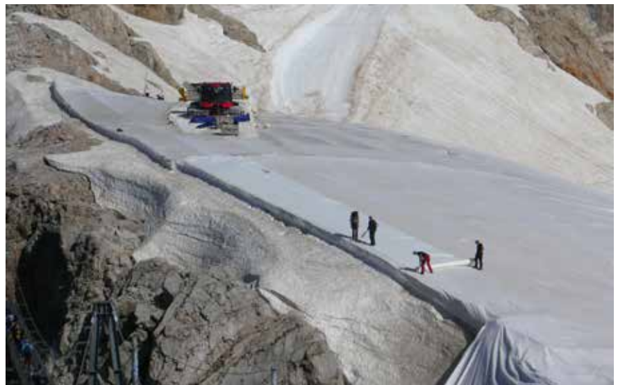
Abb. 3: Eine in allen massentouristisch erschlossenen Gletschergebieten verwendete Methode, um zumindest kleine Teile der Gletscher vor der Abschmelzung zu schützen, ist deren Abdeckung mit weißem Vlies – hier über dem „Eispalast am Dachstein“ © Lieb, 2024
